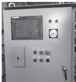
写真2 新開発! 電圧型 IGBT インバーター
